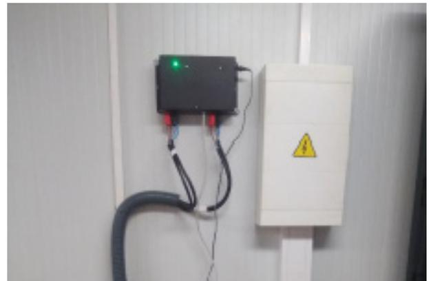
**Figura 5:** Instalación del E-Dust con tornillos en la pared de la sala de control de una planta fotovoltaica.
