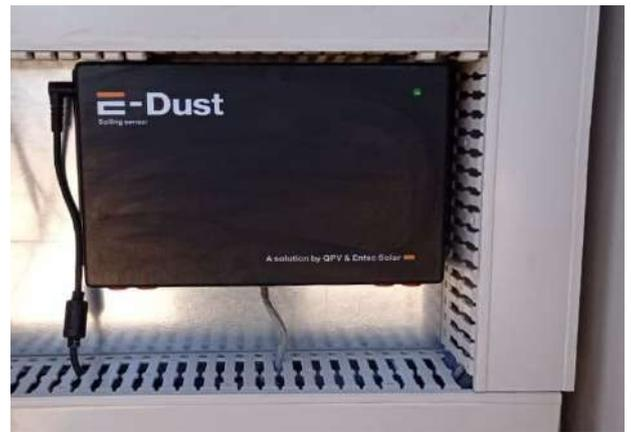
Figura 5: Instalación del E-Dust con tornillos en la pared de la sala de control de una planta fotovoltaica.
